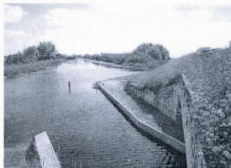
Figura 9.3 – Rampa que facilita una óptima conexión de los taludes con las plataformas secas del drenaje. Foto: H. Bekker.
