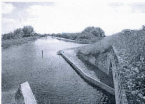
Figura 9.3 – Rampa que facilita una óptima conexión de los taludes con las plataformas secas del drenaje. Foto: H. Bekker.
