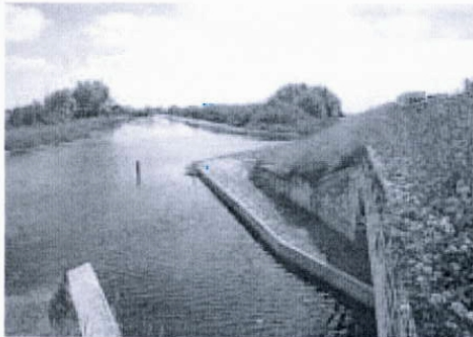
Figura 9.3 – Rampa que facilita una óptima conexión de los taludes con las plataformas secas del drenaje. Foto: H. Bekker.
